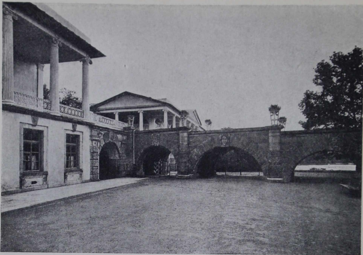
86. Термы Камерона. Пандус. Слева колоннада «Зеркальной площадки», за пандусом колоннада «Камероновой галереи»
