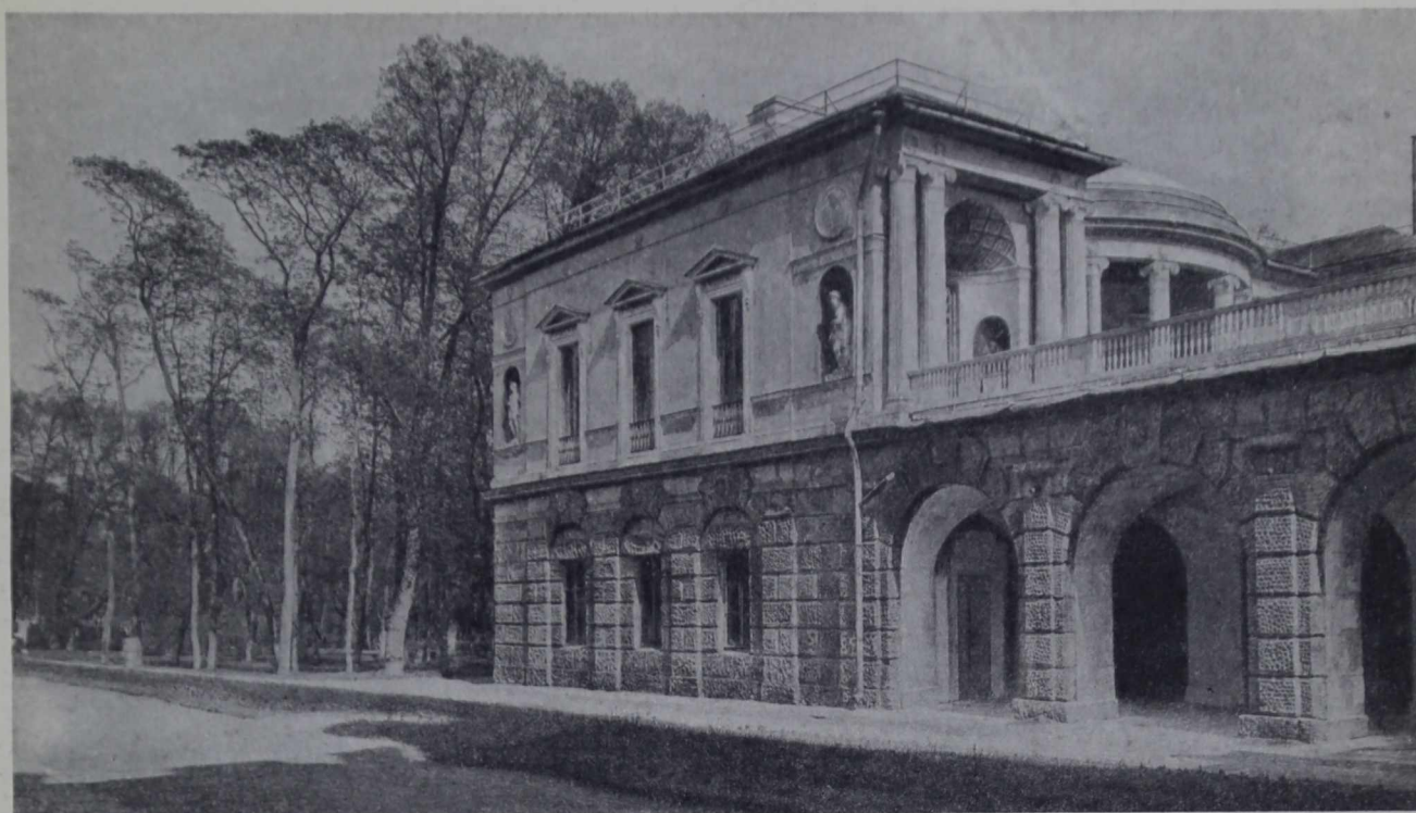
56. Термы Камерона. «Холодные бани». Вид со стороны Екатерининского дворца. Западный угол. Фасады северо-западный и юго-западный
