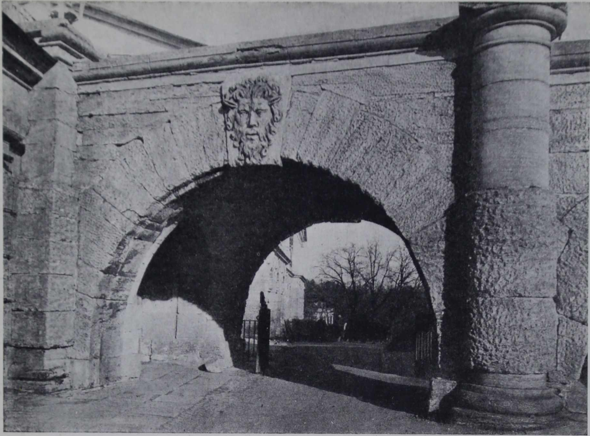
84. Термы Камерона. Пандус. Северная сторона. Первая арка от дворца. Угловой пилон. Маска Пана. Главный проезд
