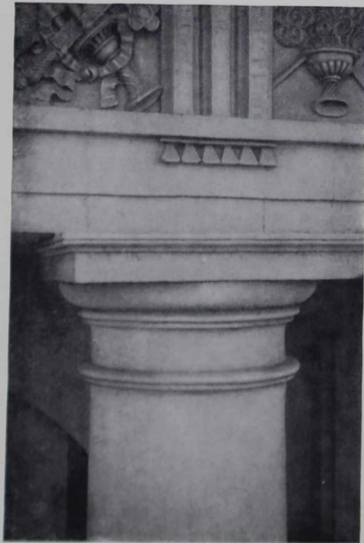
Главный портик. Детали вверху — антаблемент; внизу: слева — капитель; справа — сандрик с кронштейном
