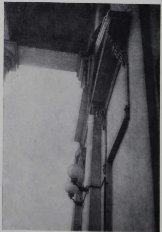
Главный портик. Детали вверху — антаблемент; внизу: слева — капитель; справа — сандрик с кронштейном
