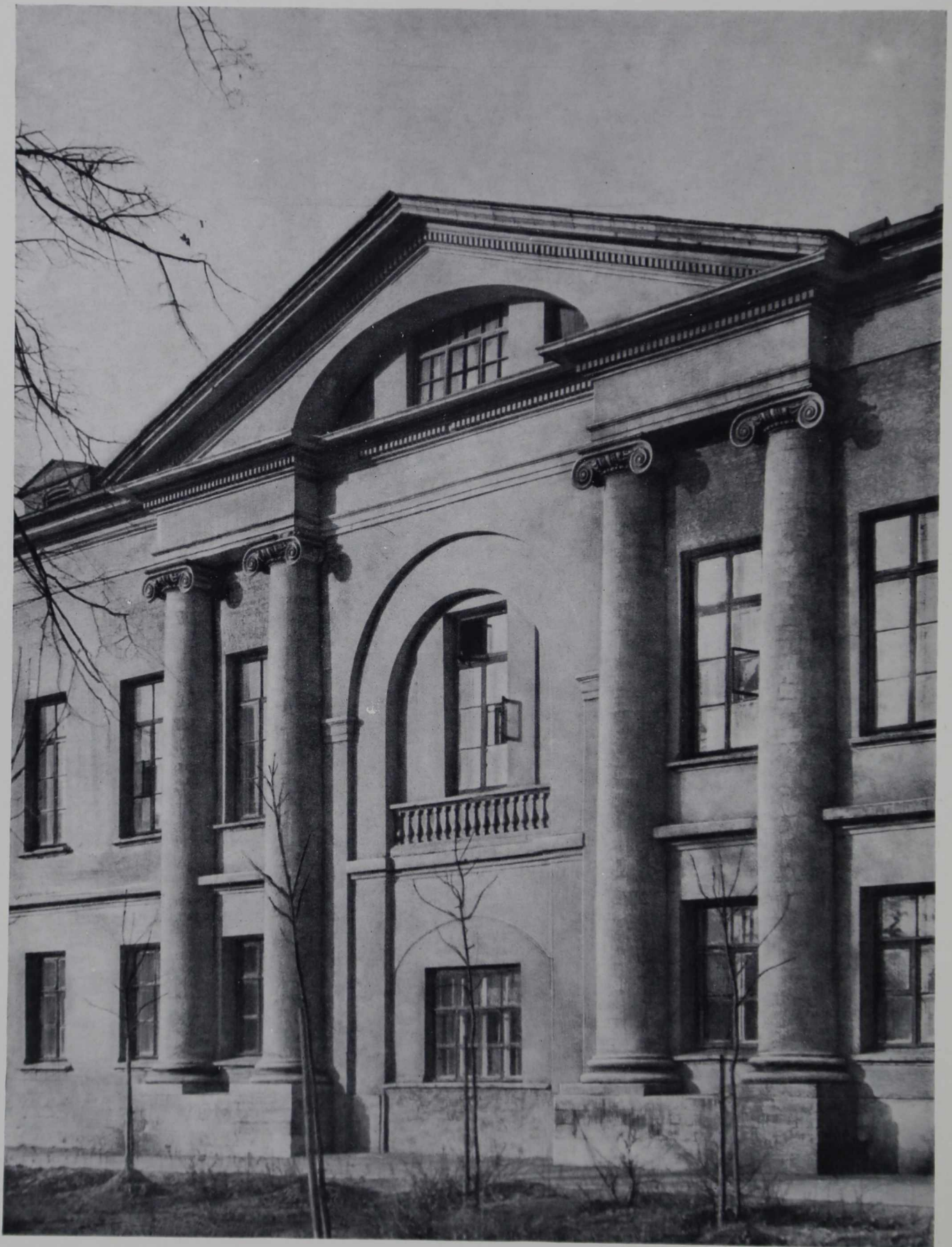
Фрагмент фасада со стороны Б. Калужской улицы. Западное крыло
