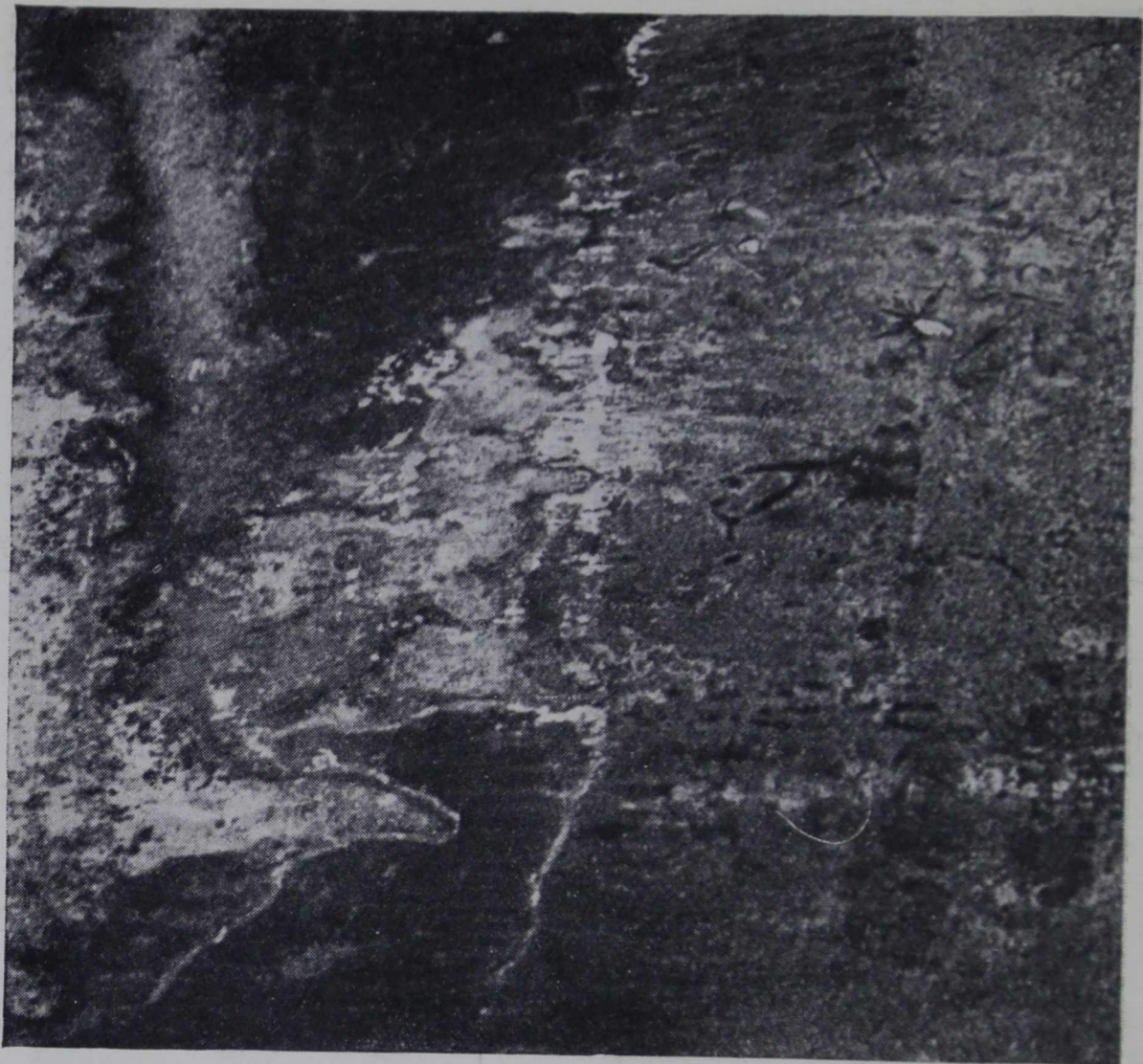
3. Высолы извести из цемента, содержащегося в растворе кладки
