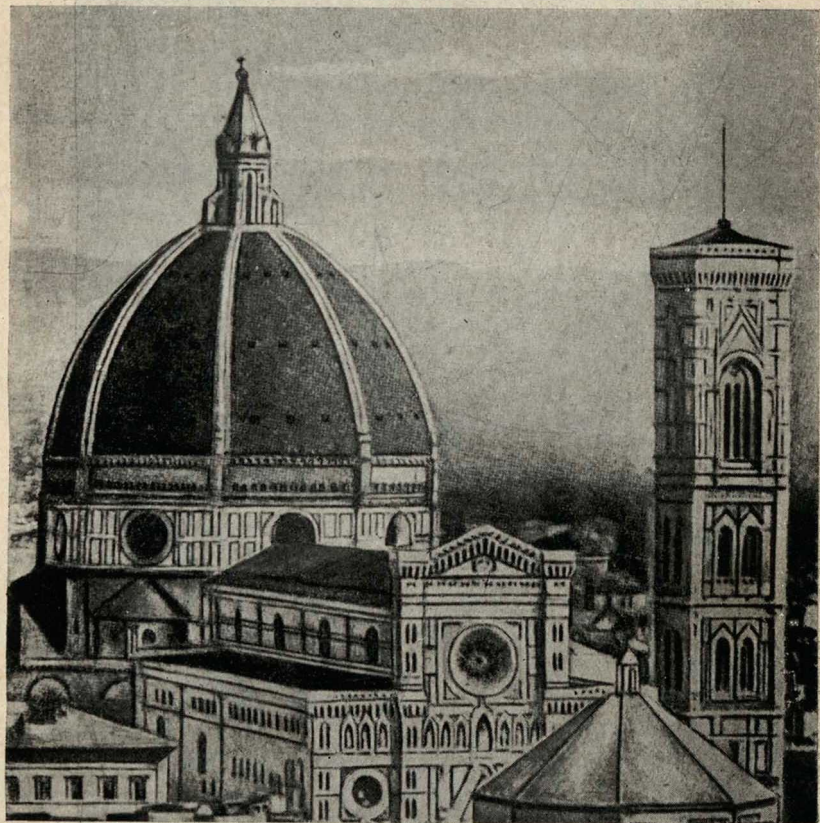
Флорентийский собор с куполом в стилс Ренессанса, возведенным Брунелеско на готической постройке. Переход от готики к Возрождению
