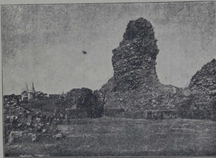
Рис. 5. Башня № XV и часть 16—17 куртин до ее окончательной раскопки (фотография снята во время раскопки).
